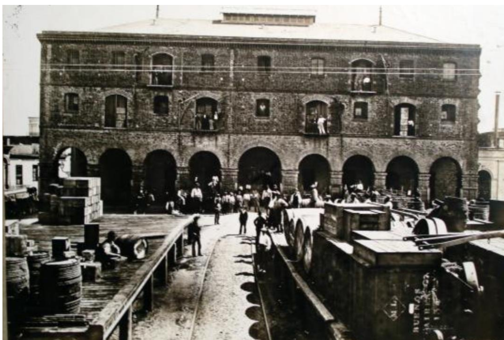
Frente del edificio del primer depósito de Las Catalinas, mirando al muelle. Este edificio y los depósitos quedaron destruidos por un incendio en 1886 (fuente Arcón de Buenos Aires)
